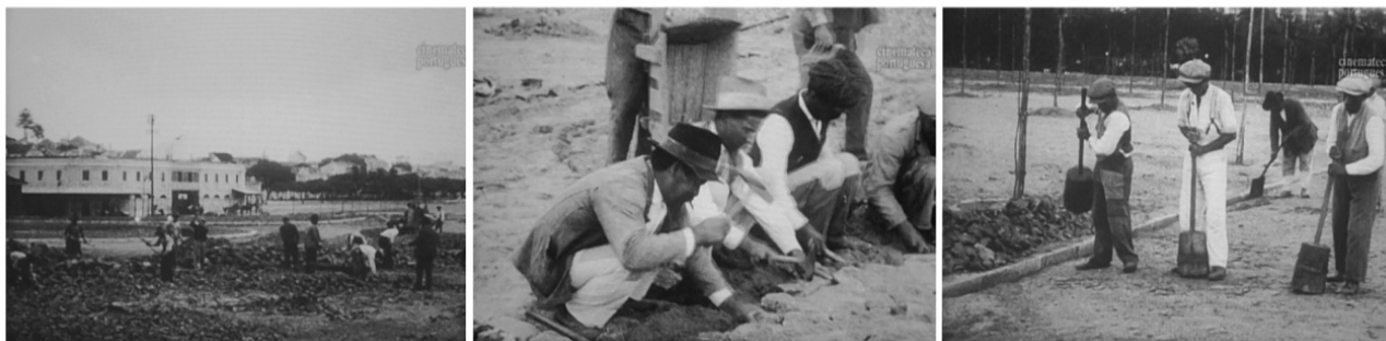
Fig. 9. Sequência de três imagens na década de 1930, em Belém, durante a elaboração de calçada à portuguesa. Corte da pedra (cortadores de pedra), colocação (calceteiros) e o batimento (batedores de maço).
