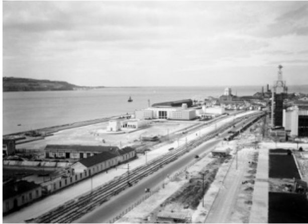
Fig. 10. Pode-se ver nesta foto durante a elaboração da Exposição do Mundo Português, no canto inferior direito, uma pequena barraca no local da edificação da principal calçada artística a sul. Esta serviria como estaleiro e lugar de guarda dos moldes e materiais dos calceteiros.
